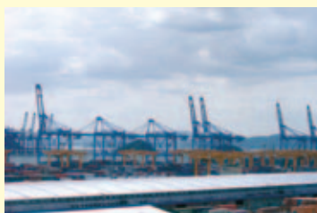
釜山港ガントリークレーン
